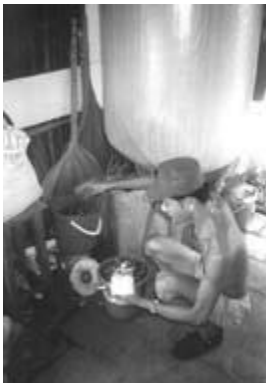
PHOTO/FOTO 6 A vertical biogas storage bag Sac vertical de stockage du biogaz Bolsa vertical para almacenar el biogás Photo/Foto: Lylian Rodríguez
