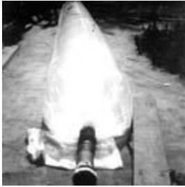
PHOTO/FOTO 5 A plastic tube ready for installation Tube plastique prêt à être installé Tubo de plástico listo para su instalación Photo/Foto: Lylian Rodríguez
