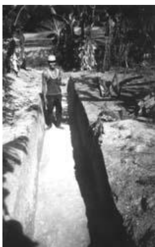
PHOTO/FOTO 3 The width of the trench varies according to the size of the tube La largeur de la tranchée varie selon les dimensions du tube El ancho de la zanja varía de acuerdo con las dimensiones de la tubería Photo/Foto: Lylian Rodríguez
